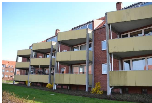
Altanløsning på det nordlige afsnit. Det er en søjlekonstruktion i beton med en trekantet form på altanen, som misklæder bygningerne.
