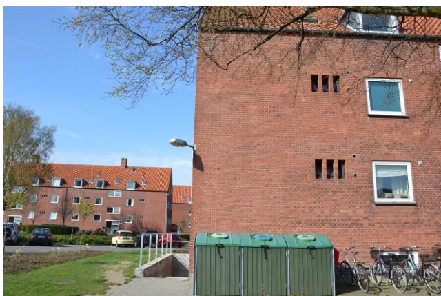
Udendørsbelysning på bygningshjørnerne.
