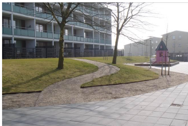
Eksempel på terrænregulering af areal foran terrasse til tilgængelig ankomst til stuelejligheder.
