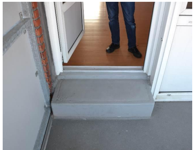
Den oprindelige altankumme blev fyldt op og fungerer som trappetrin til den nye altan. Det er en detalje, som beboerne ikke er glade for pga. den manglende tilgængelighed.
