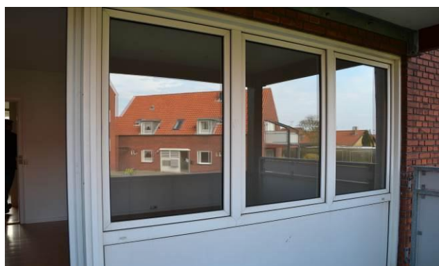
Vinduespartiet er nedslidt og bør udskiftes til et nye energioptimeret vinduesparti.
