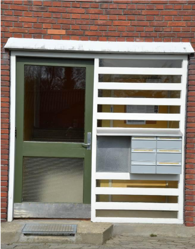
Indgangsdør på det sydlige afsnits nordfacade.
