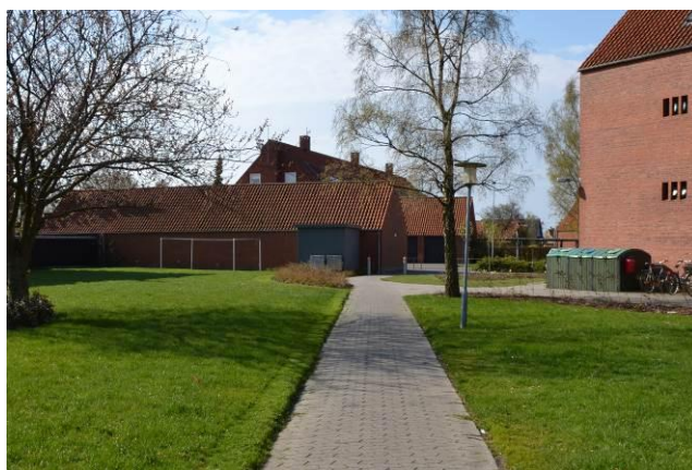
Adgangsvejen til bebyggelsen er generelt imødekommende med gode flisebelagte stier.
