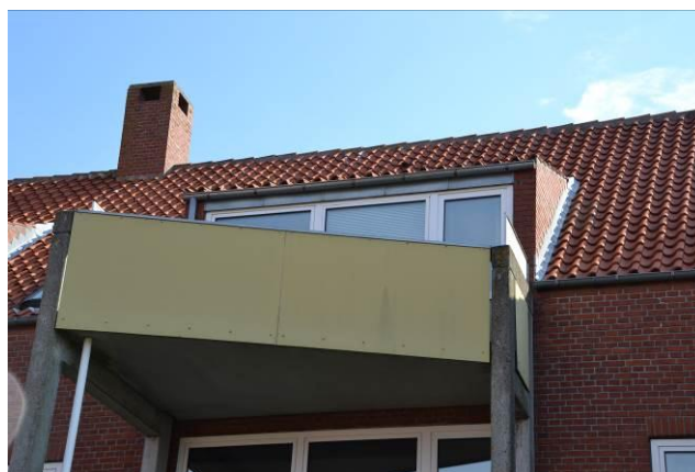
Taskekviste på sydsiden af bygningerne. Bør efterisoleres.
