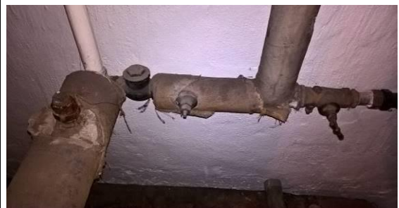
Vandinstallation og isolering i kælder.
