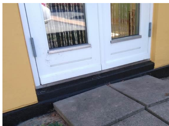
Terrassedør ved forhuset er udført i træ
