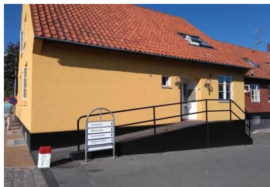
Rampe ved forhuset
