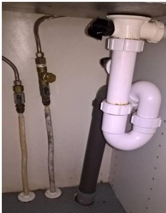
Afløb for køkkenvask i køkken.
