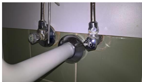
Tegn på tæring/utætheder ved afspærringsventiler under håndvask i badeværelse.
