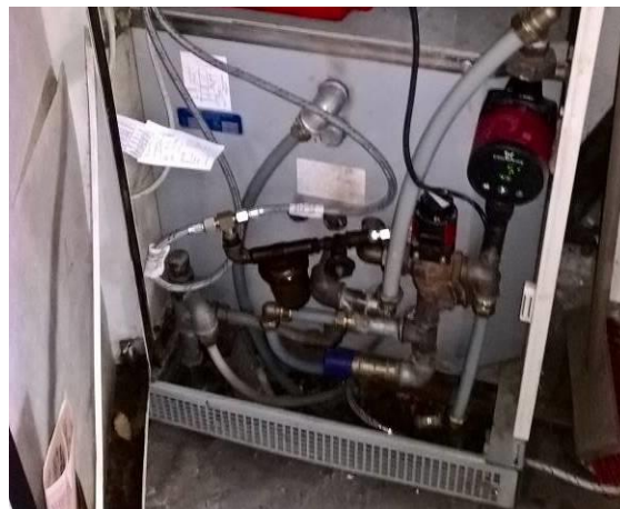
Varmtvandsbeholder i oliekedel i fyrrum.
