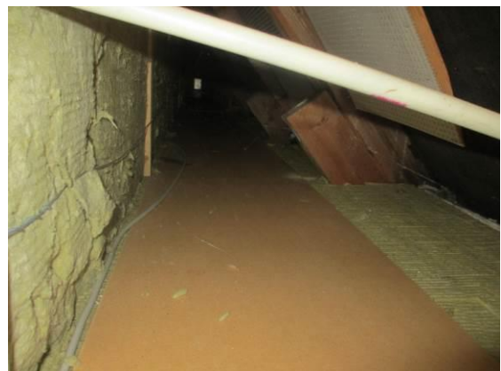
Skunk med isolering og udlagt masonitplade
