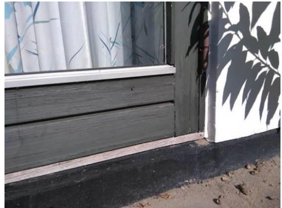
Højt trin ved terrassedøre
