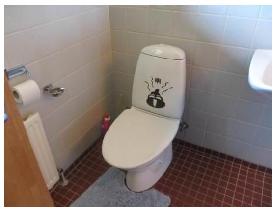
Klinkegulv i bad
