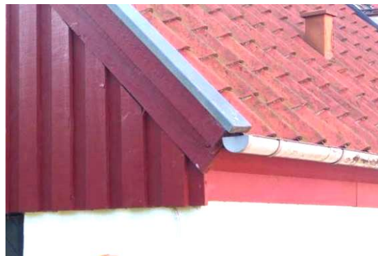
Vindskeder udført med zinkafdækning ved nr. 31
