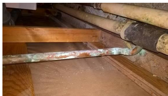
Udvendig tæring på koldtandsrør i skunk på 1.sal.
