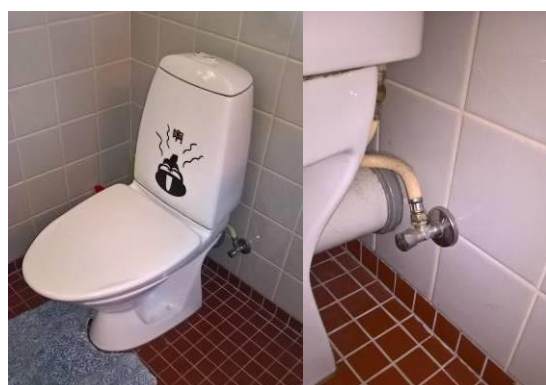
Toilet i badeværelse på 1.sal.
