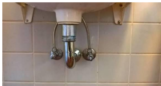
Afløb fra håndvask i badeværelse.
