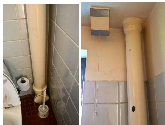
Faldstamme med rensestykke i badeværelse, ført til 1.sal. Tegn på tæring på faldstamme.
