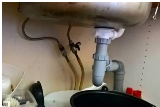
Afløb i køkkenskab for køkkenvask i stueetage.
