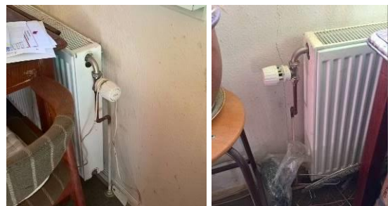
Nyere udskiftet radiator termostatventil.
