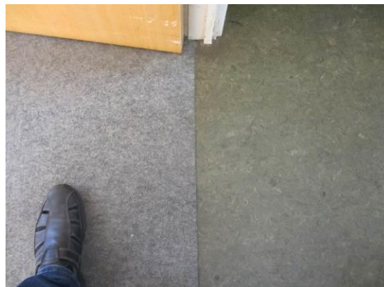
Linoleum og filt i stueetage
