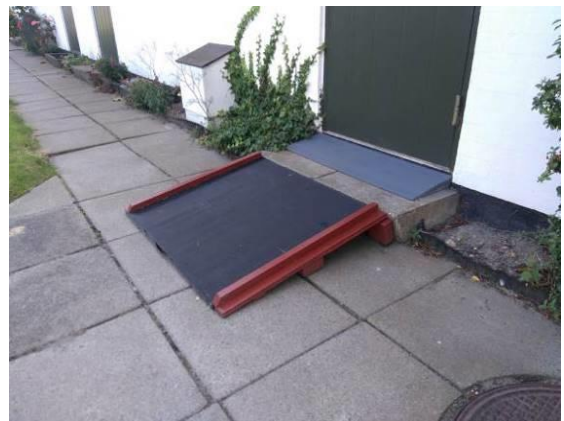
Interimistisk rampeløsning ved indgangsdør
