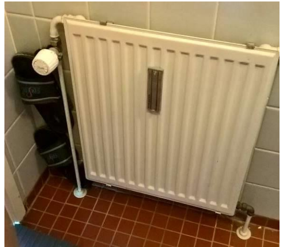
Radiator i badeværelse i stueetage.
