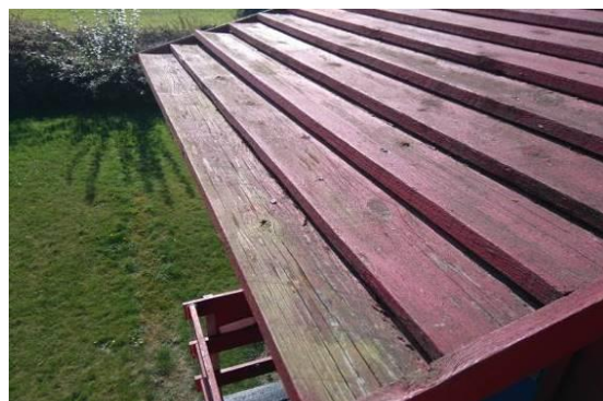
Overdækninger udført med brædder
