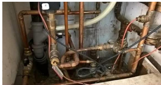
Afløb i teknikskab for overløb fra sikkerhedsventil på varmtvandsbeholder i stueetage.
