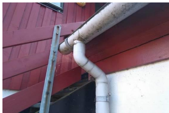
Sternbrædder ved facader er udført i træ
