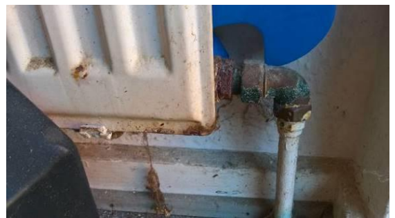
Tæring på radiator i entre i stueetage.
