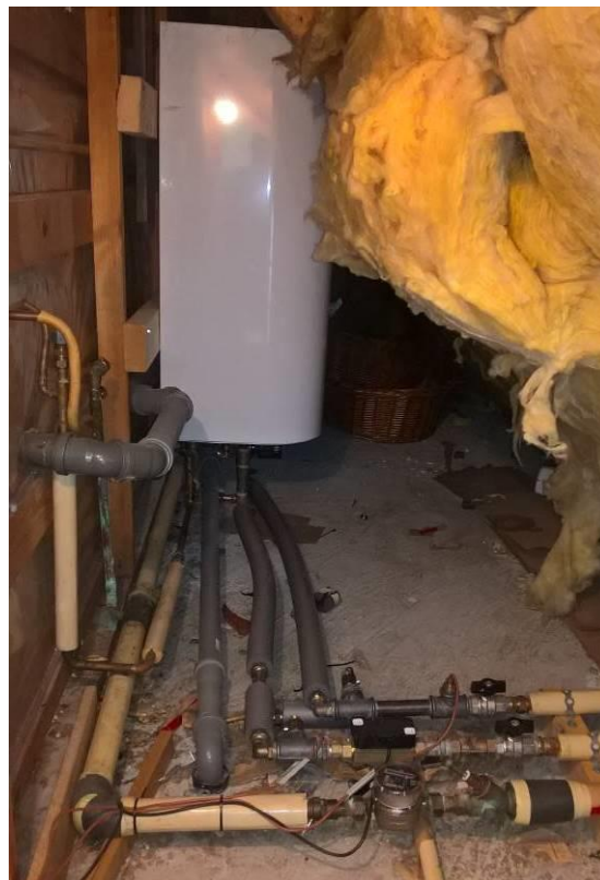
Varmtvandsbeholder 60 l. i skunk på 1.sal.
