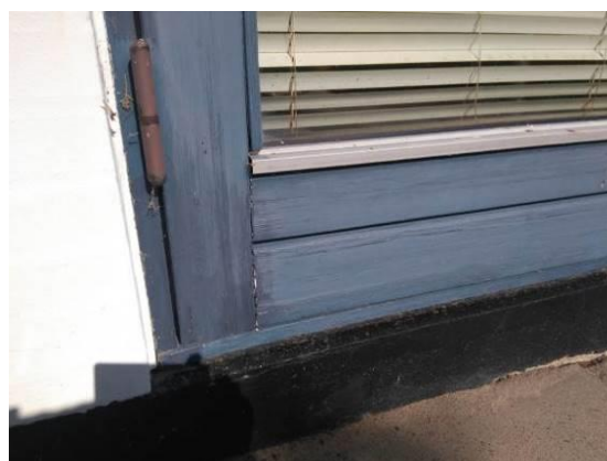
Terrassedøre i træ, kraftig nedbrydning
