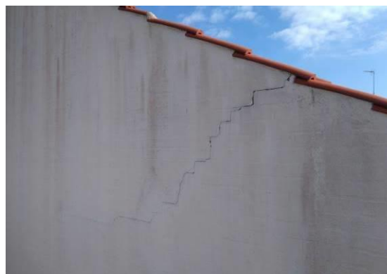
Sætningsrevne ved gavlmurvinge mod haven – nr. 13
