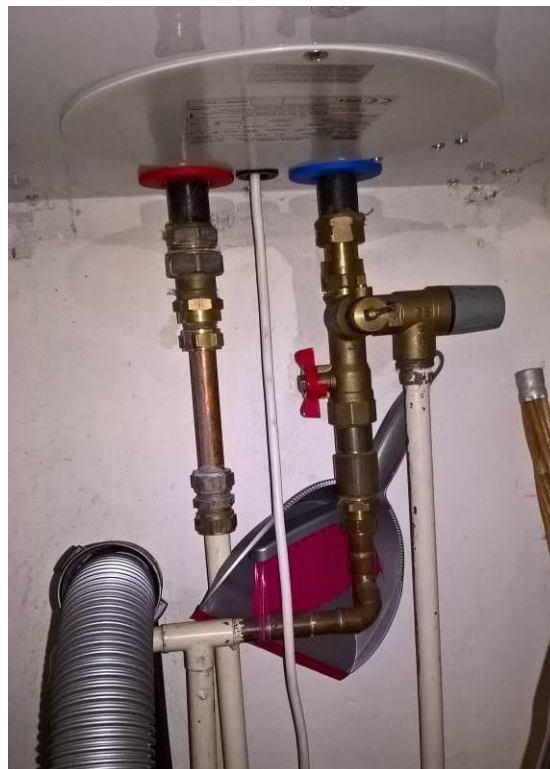
Tilslutning til varmtvandsbeholder i teknikskab. Tegn på tæring ved samling på varmtvandsrør.
