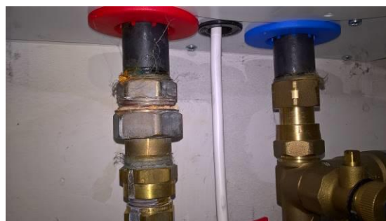
Tæring/utæthed ved tilslutning til varmtvandsbeholder
