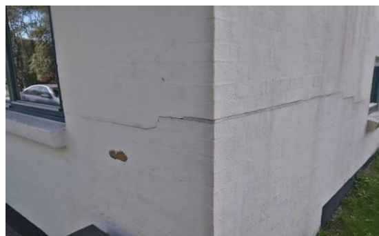
Vandret revne rundt om bygningshjørne – nr. 13
