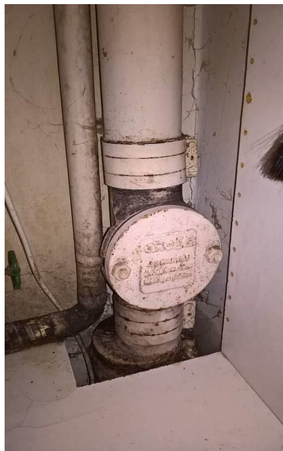
Faldstamme med rensestykke i teknikskab, ført til 1.sal.
