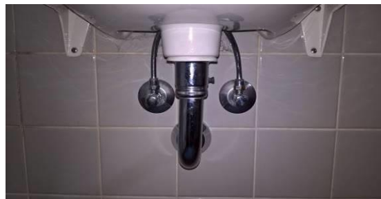
Afløb fra håndvask i badeværelse.
