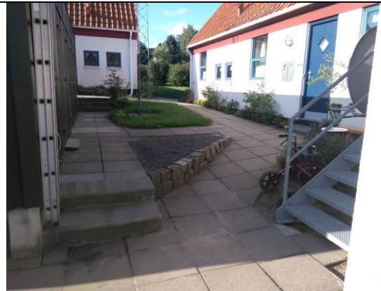
Flisearealer med opbygget rampe
