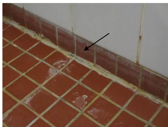
Dårlig fuge ved sokkel i bad
