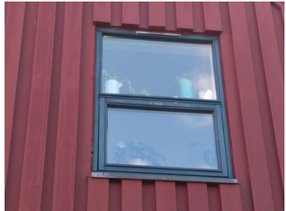
Vindue i trægavl
