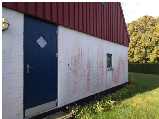
Gavl mod nord med algevækst
