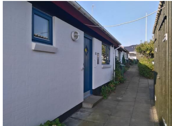
Flisebelægninger hen langs bygninger
