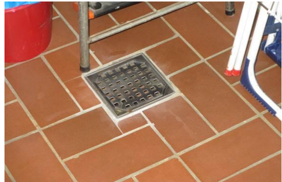
Klinkegulv med gulv afløb i bad
