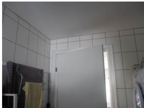
Flisebeklædning på vægge i bad
