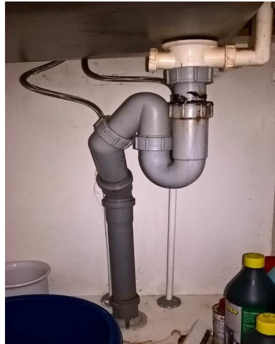
Afløb under køkkenvask. Tegn på utætheder ved omløber på vandlås.
