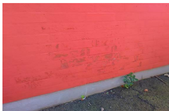
Opstigende fugt og afskalninger
