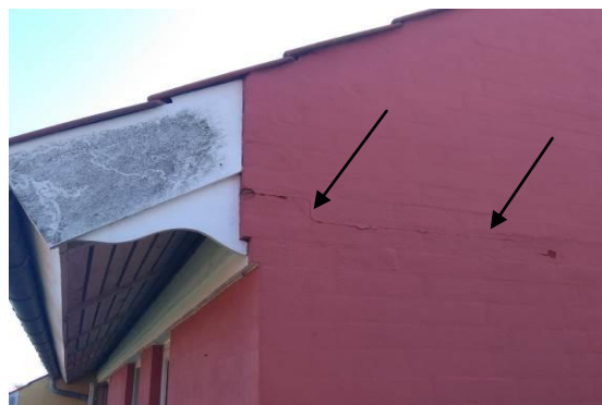
Vandret revne ved gavltrekant nr. 11
