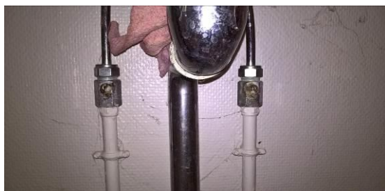
Utætheder omkring spindel på afspærringsventiler for håndvask i badeværelse.
