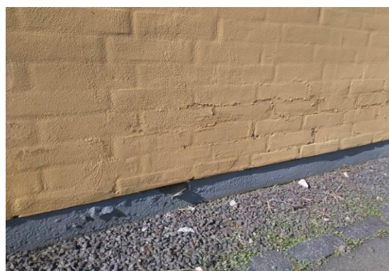
Opstigende fugt i det nederste gavlmurværk
