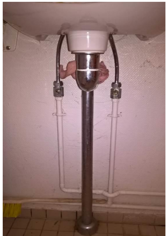
Afløb under håndvask på badeværelse. Tegn på utæthed/tæring omkring samling på afløbsrør.
