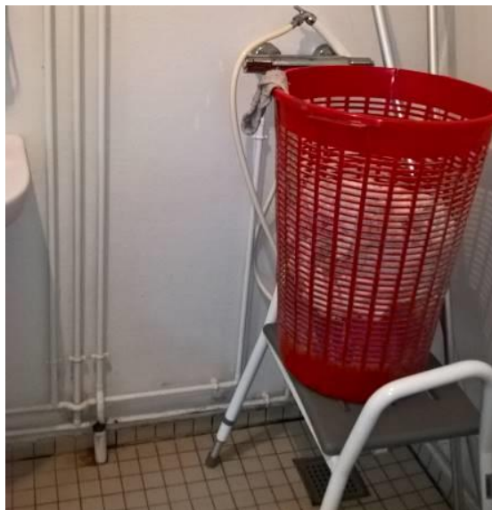
Vandinstallation synligt på væg i badeværelse.
