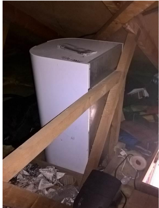
Varmtvandsbeholder placeret i tagrum.
