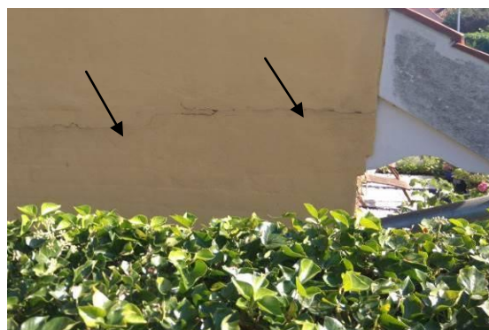
Vandret revne ved gavltrekant nr. 5
