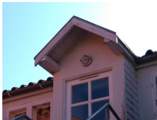
Vindskedebræt over trappe til 1. sal
