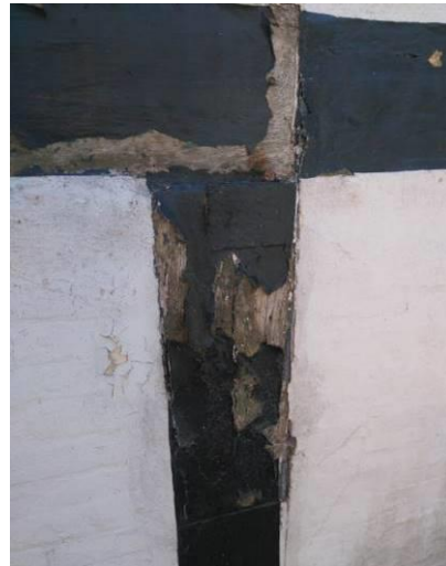
Bindingsværk med skader og afskallet maling
