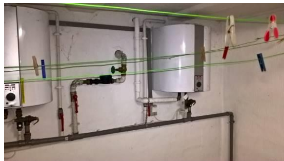
Varmtvandsbeholdere i kælder.
