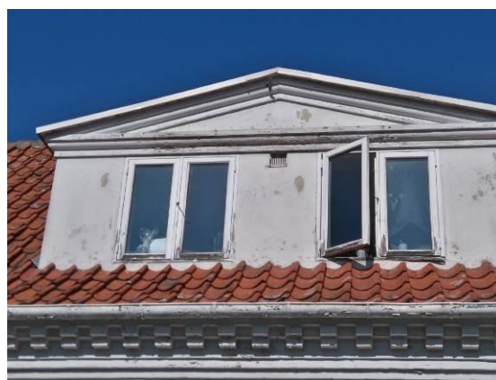
Trævinduer mod gaden – under kraftig nedbrydning
