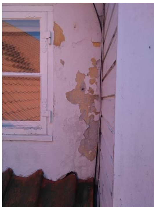
Afskalninger ved facade på 1. sal
