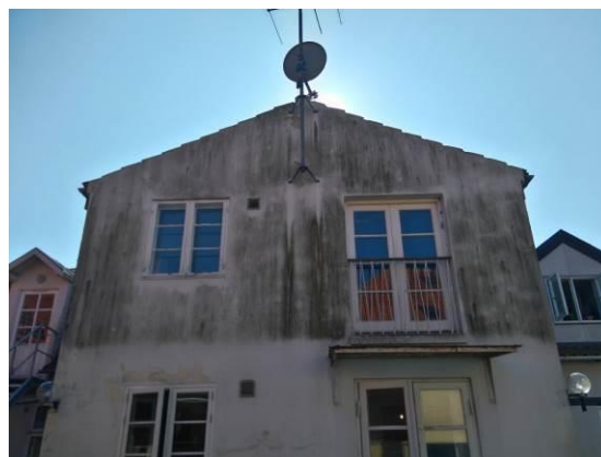
Alge­vækst ved nordgavl
