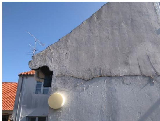
Kraftig revne i gavl mod vest
