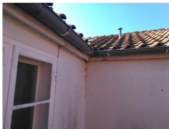
Plade-/bræddegesims mod gården
