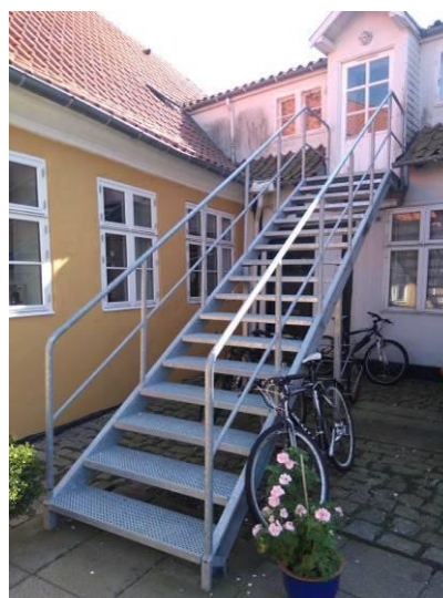
Nyere galvaniseret ståltrappe i gården
