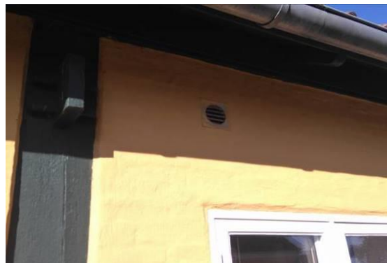
Bygning N – synlige spærrender
