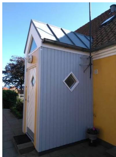
Bygning S – vindfang/trappeopgang mod gården
