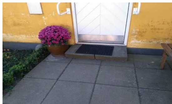
Trappetrin ved bygning S
