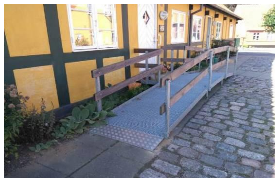
Midlertidig rampe ved bygning V
