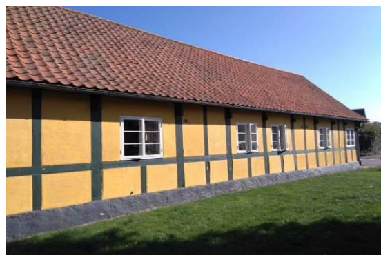
Bygning V – facade mod vest
