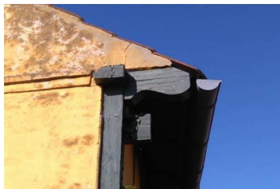
Bygning V – synlige spærrender
