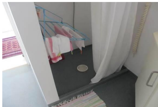
Bad på 1. sal ved bruseniche med vinylopkant / gulvafløb
