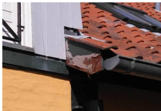
Bygning N – vindskedeplade ved tagkvist
