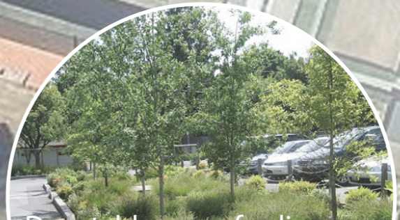
Der etableres en frodig grøn grøft til nedsvivning af regnvand langs parkeringsareal og plads
