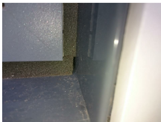
Fugebånd slutter ikke tæt
