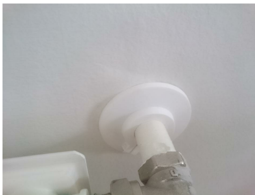
Løs filt registreret bag radiator i stuen
