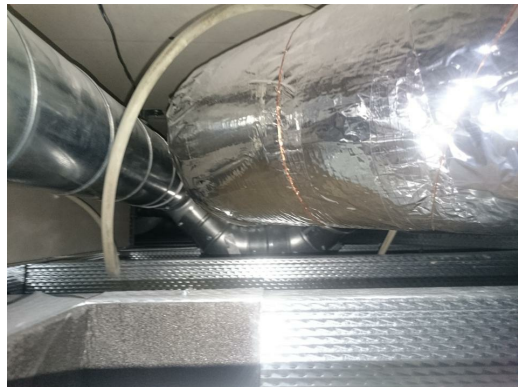
Installation ført rundt langs et ventilationsrør
