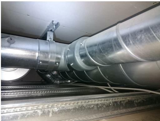
Installationer ikke fastgjort
