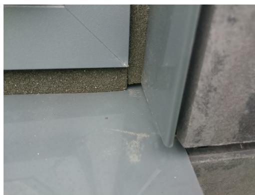
Fugebånd slutter ikke tæt, Fabriksvej 38
